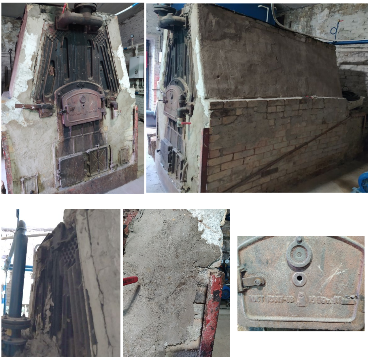
Рисунок 1.61 – Внешний вид котлоагрегата КЧ-1 (завод им. Войкова)
