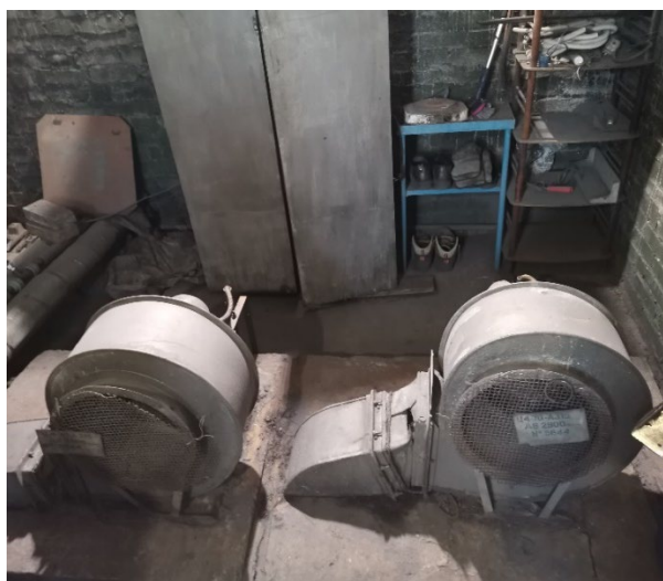
Рисунок 1.73 – Внешний вид вентиляторов дутьевых котлоагрегатов Универсал-6 ст. № 1, ст. № 2, нарушение герметичность воздуховода, неплотность соединения воздуховода к корпусу вентилятора
