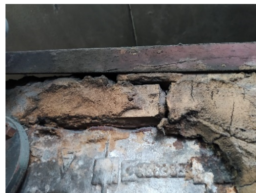
Рисунок 1.65 – Внешний вид водогрейного котлоагрегата Универсал-5, ст. № 1: нарушение целостности конструкции котлоагрегата
