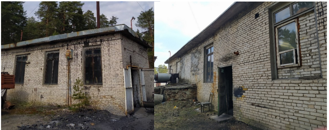
Рисунок 1.55 – Общий вид и состояние наружных конструкций здания котельной ДРСУ (г. Приозерск, ул. Сосновая, 1)
