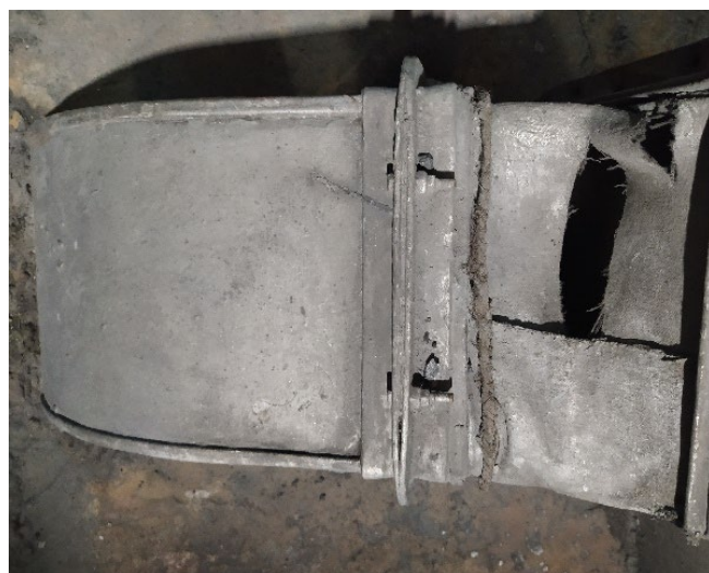
Рисунок 1.73 – Внешний вид вентиляторов дутьевых котлоагрегатов Универсал-6 ст. № 1, ст. № 2, нарушение герметичность воздуховода, неплотность соединения воздуховода к корпусу вентилятора
