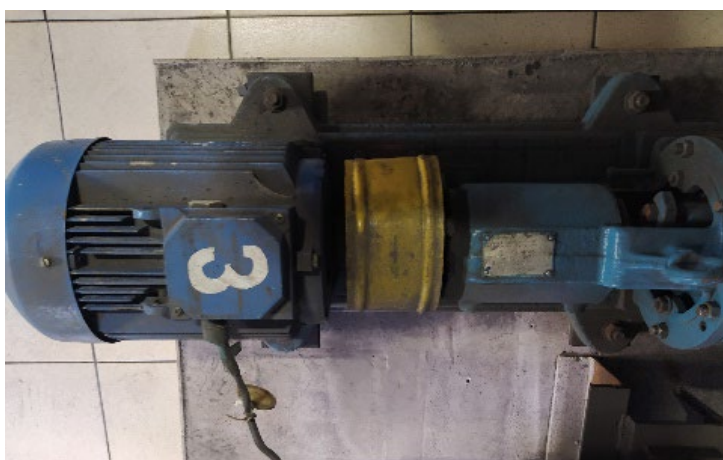
Рисунок 1.71 – Внешний вид сетевого насоса К65-50-160С ст. № 3 и его электродвигателя
