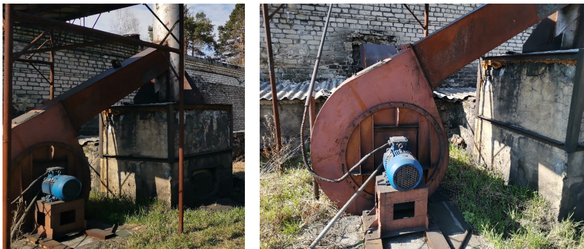
Рисунок 1.70 – Внешний вид общего для всех котлоагрегатов дымососа Д 10
