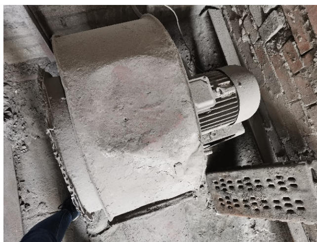
Рисунок 1.67 – Внешний вид дутьевого вентилятора котлоагрегата Универсал-5 ст. № 1
