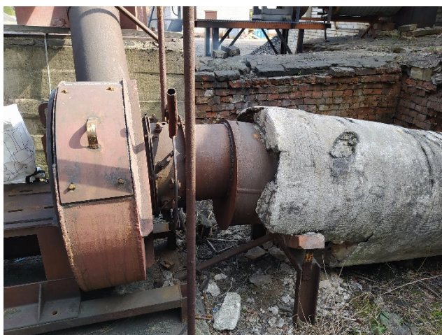
Рисунок 1.68 – Внешний вид дымососа котлоагрегата Универсал-5 ст. № 1 (на момент проведения технического обследования был снят электродвигатель, планировалась его замена)
