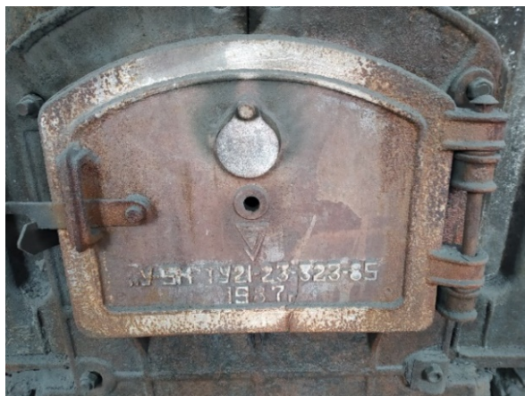
Рисунок 1.64 – Внешний вид водогрейного котлоагрегата Универсал-5, ст. № 1
