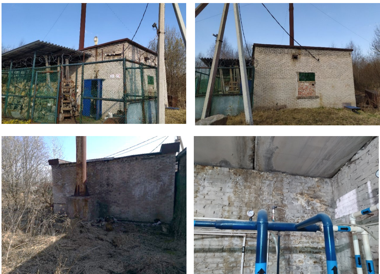
Рисунок 1.53 – Общий вид и состояние конструкций здания котельной (г. Приозерск, ул. Цветкова, 43а)
