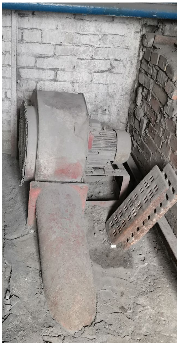
Рисунок 1.67 – Внешний вид дутьевого вентилятора котлоагрегата Универсал-5 ст. № 1
