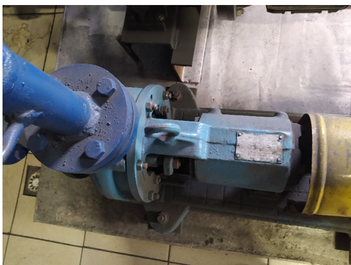
Рисунок 1.70 – Внешний вид общего для всех котлоагрегатов дымососа Д 10
