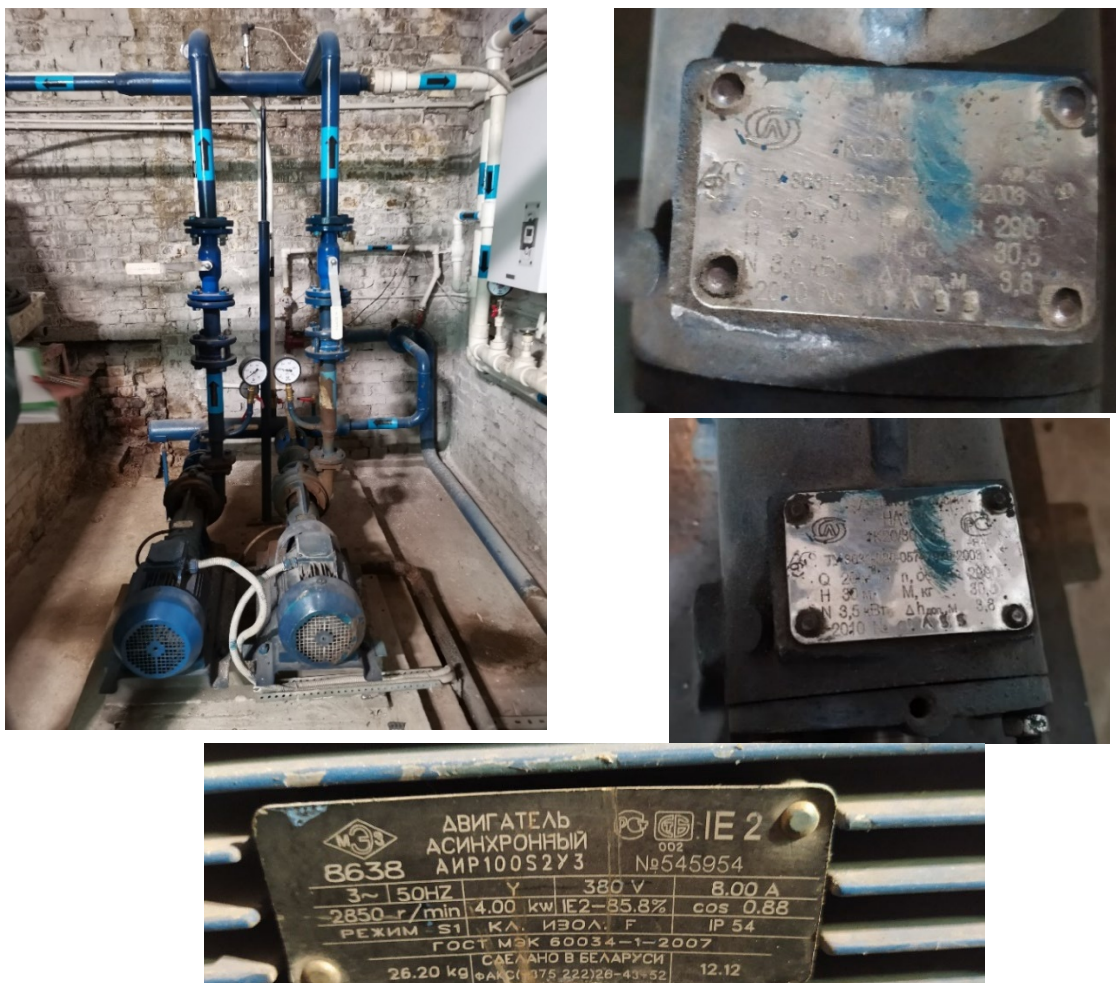
Рисунок 1.62 – Внешний вид сетевых насосов 1К 20/30 № 1, № 2
