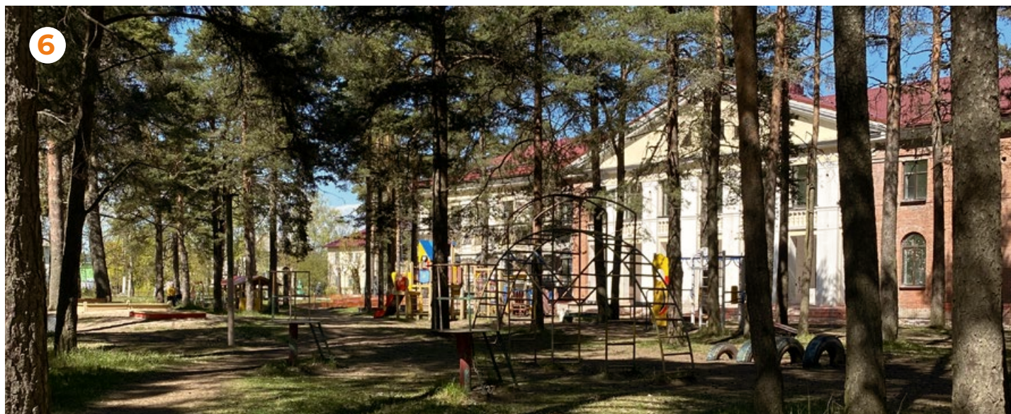
6 Перед входом в ДК организована детская игровая площадка. Оборудование устаревшее, состояние покрытий неудовлетворительное, газоны вытоптаны. Требуется обновить площадку, создать новое привлекательное для детей и их родителей место, подходящее для активного отдыха и игр на свежем воздухе. Необходимо предусмотреть зоны для разных возрастных категорий: для детей постарше и для младшей возрастной группы.
