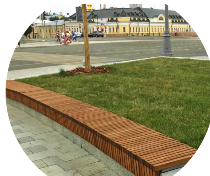
Скамья на бетонном основании
