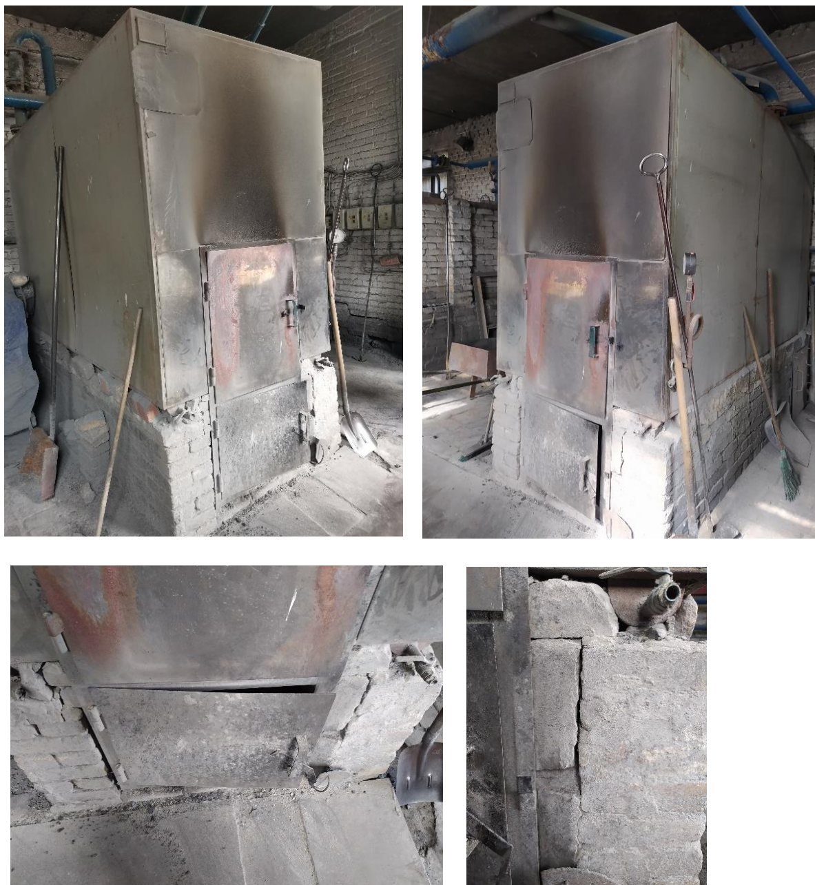
Рисунок 1.66 – Внешний вид водогрейного котлоагрегата Луга-Лотос КВР-1,5 в легкой обмуровке, ст. № 2: нарушение целостности конструкции котлоагрегата
