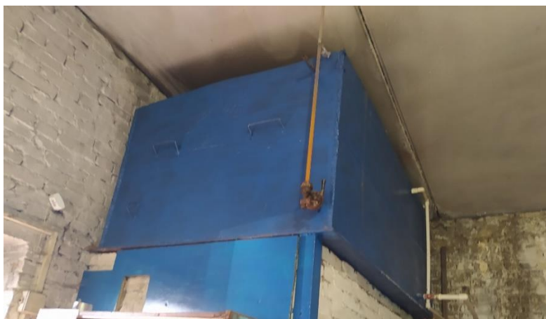
Рисунок 1.63 – Внешний вид бака запаса холодной воды ( V = 2,5 \text{ м}^3 )
