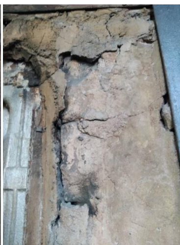
Рисунок 1.65 – Внешний вид водогрейного котлоагрегата Универсал-5, ст. № 1: нарушение целостности конструкции котлоагрегата
