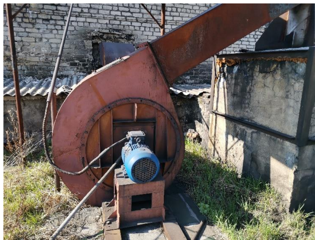
Рисунок 1.70 – Внешний вид общего для всех котлоагрегатов дымососа Д 10
