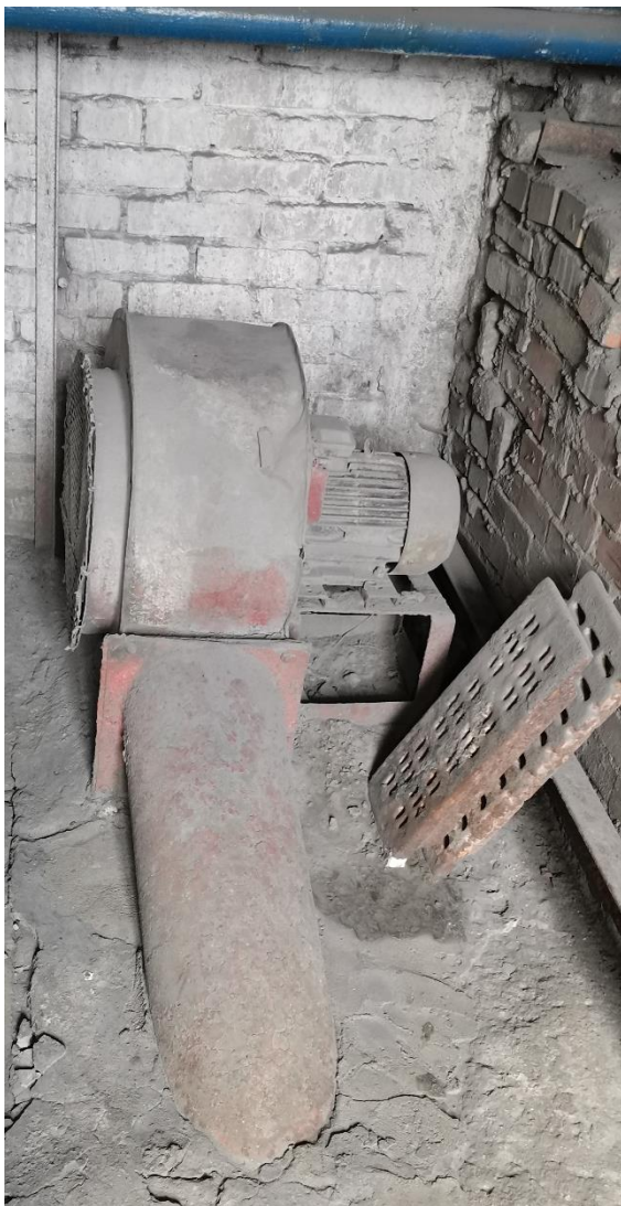
Рисунок 1.67 – Внешний вид дутьевого вентилятора котлоагрегата Универсал-5 ст. № 1
