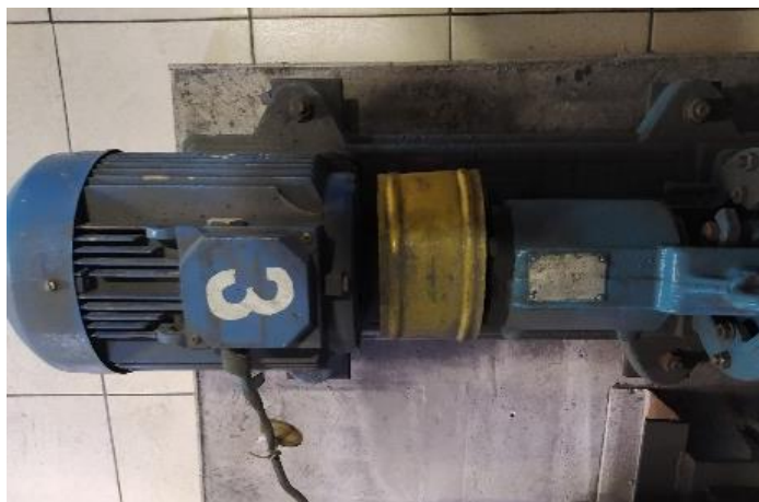
Рисунок 1.71 – Внешний вид сетевого насоса К65-50-160С ст. № 3 и его электродвигателя
