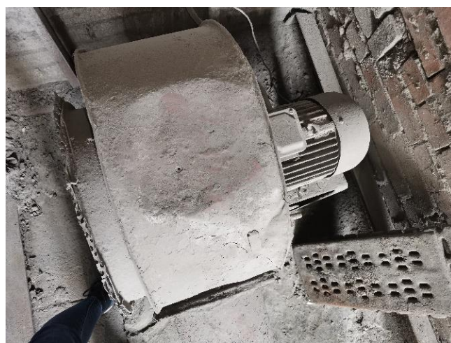
Рисунок 1.67 – Внешний вид дутьевого вентилятора котлоагрегата Универсал-5 ст. № 1
