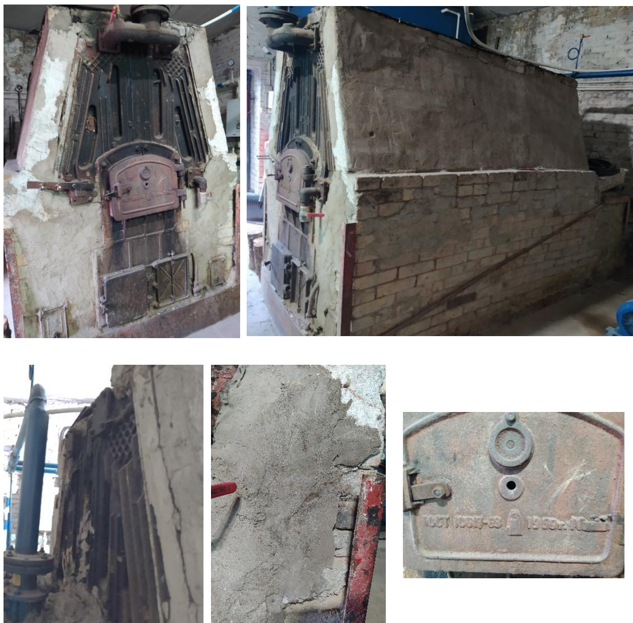
Рисунок 1.61 – Внешний вид котлоагрегата КЧ-1 (завод им. Войкова)
