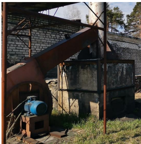
Рисунок 1.70 – Внешний вид общего для всех котлоагрегатов дымососа Д 10
