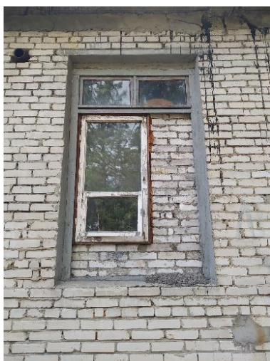
Рисунок 1.56 – Общий вид и состояние наружных конструкций здания котельной № 4 (г. Приозерск, ул. Сосновая, 1)
